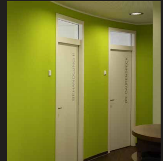
Mehrzwecktüren für den Objekteinsatz Stahlzargen mit Oberlicht
