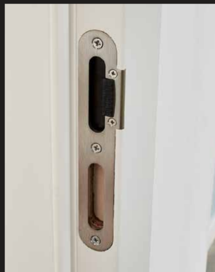
Detail: Magnetfallschließblech zum Verstellen
